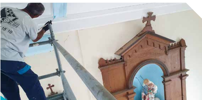
Réfection de la toiture de l'église Sainte-Rose de Lima du bourg
