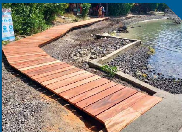
Face à l'érosion, la ville a procédé à des travaux d'amélioration de l'accès à l'îlet.
