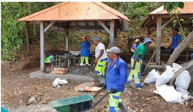
Réfection des kiosques de l' ilet Madame
