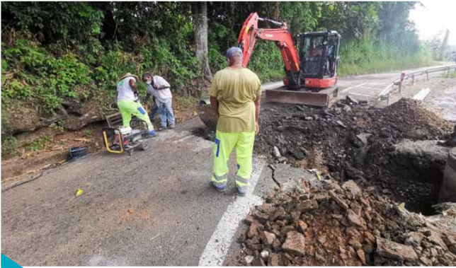
Canalisation des eaux pluviales au quartier Augrain
