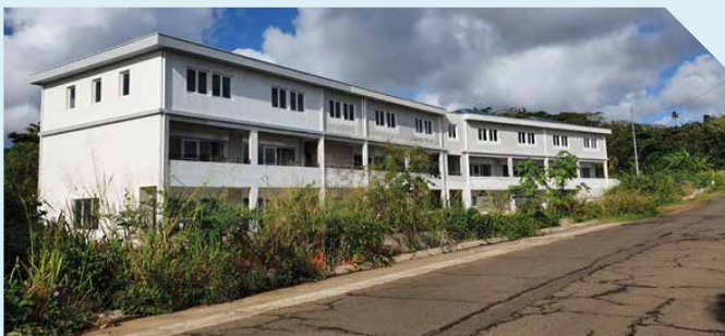
Zone de Mansarde Nord
