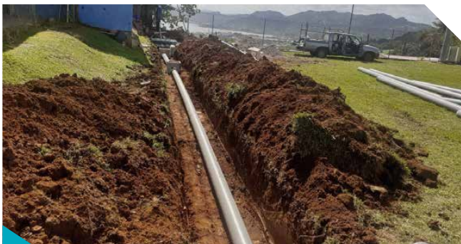
Remplacement de la fosse septique au local associatif de Lestrade
