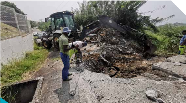
Canalisation des eaux pluviales au quartier Pointe Savane
