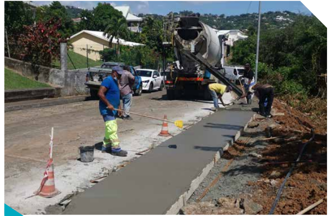
Réfection des trottoirs du cimetière de Mansarde
