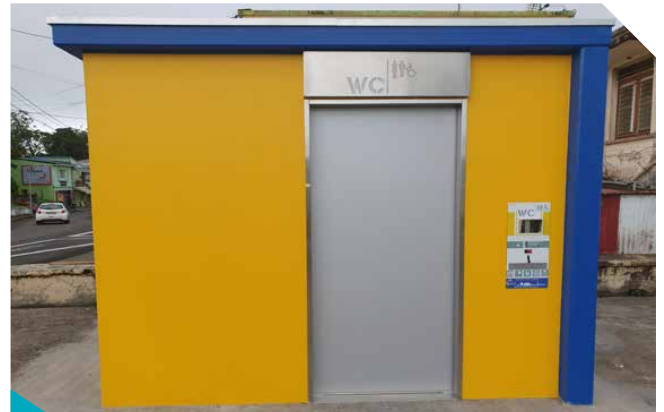
Installation d'un nouveau sanitaire automatique au Vert-Pré
