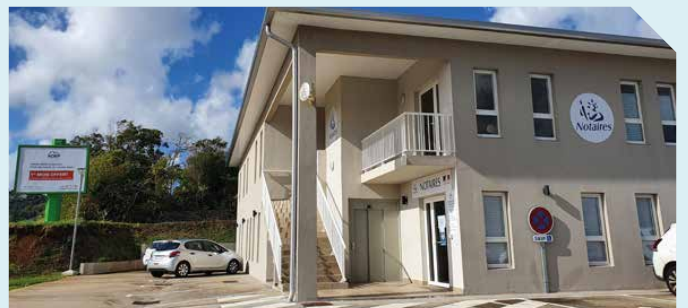
Zone de Mansarde Nord
