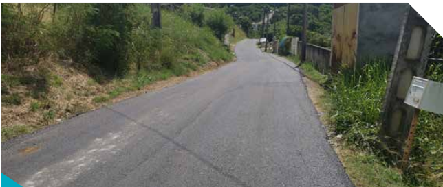
Réfection d'une portion de la route de Pointe Hyacinthe
