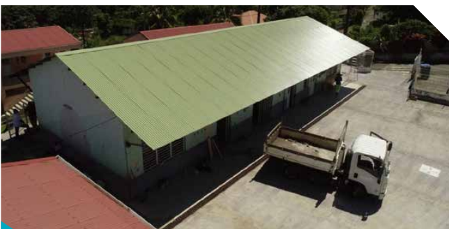
Réfection de la toiture de l'école Couronnée Lourel de Café
