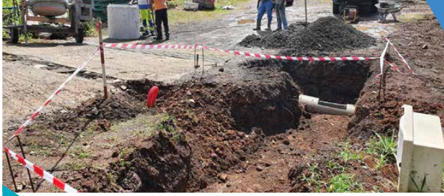
travaux de canalisation des eaux de pluies à Bouteaud
