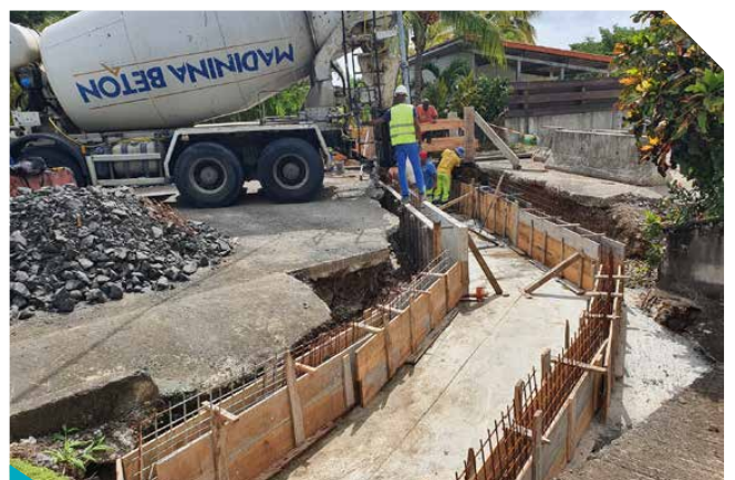
Réfection de pont à Pointe Savane , situé à l'avenue des Cayalis
