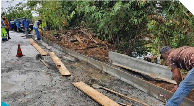
Canalisation des eaux pluviales à Croisée Lecomte/RD1
