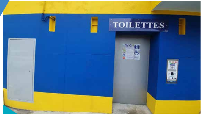
Installation de nouveaux sanitaires automatiques rue Lucien Belus et Boulevard Henry Auzé
