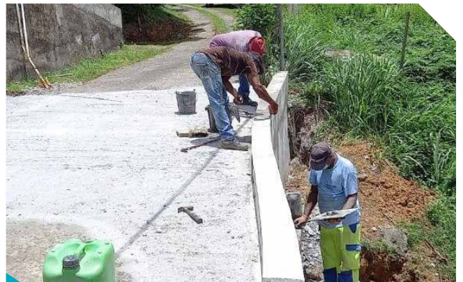
Réparation de la route de Bresson
